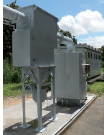
アマノ製 Bag-In・Bag-Out 式集塵機を採用 爆発試験時の排気ガス処理に対応
